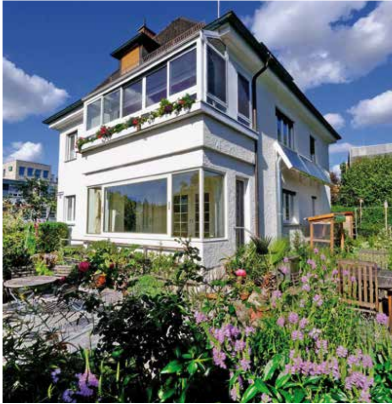
Eine Solarlüftung an der Südfassade sorgt jetzt für ein besseres Raumklima im Keller. Foto: djd/GRAMMER Solar GmbH
