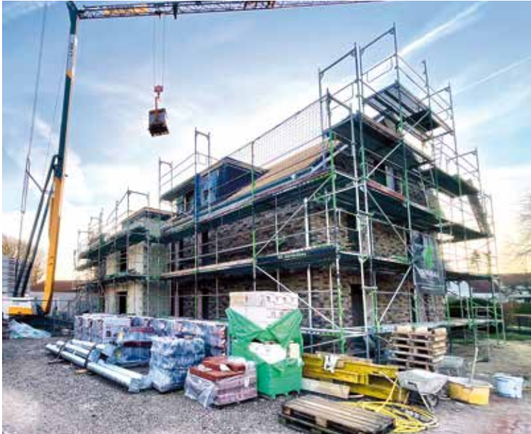
Hier ein Foto von der Baustelle für die Wohnanlage in Rahden, die am Sonntag, dem 25. Februar 2024, von 14.00 bis 16.00 Uhr besichtigt werden kann.
