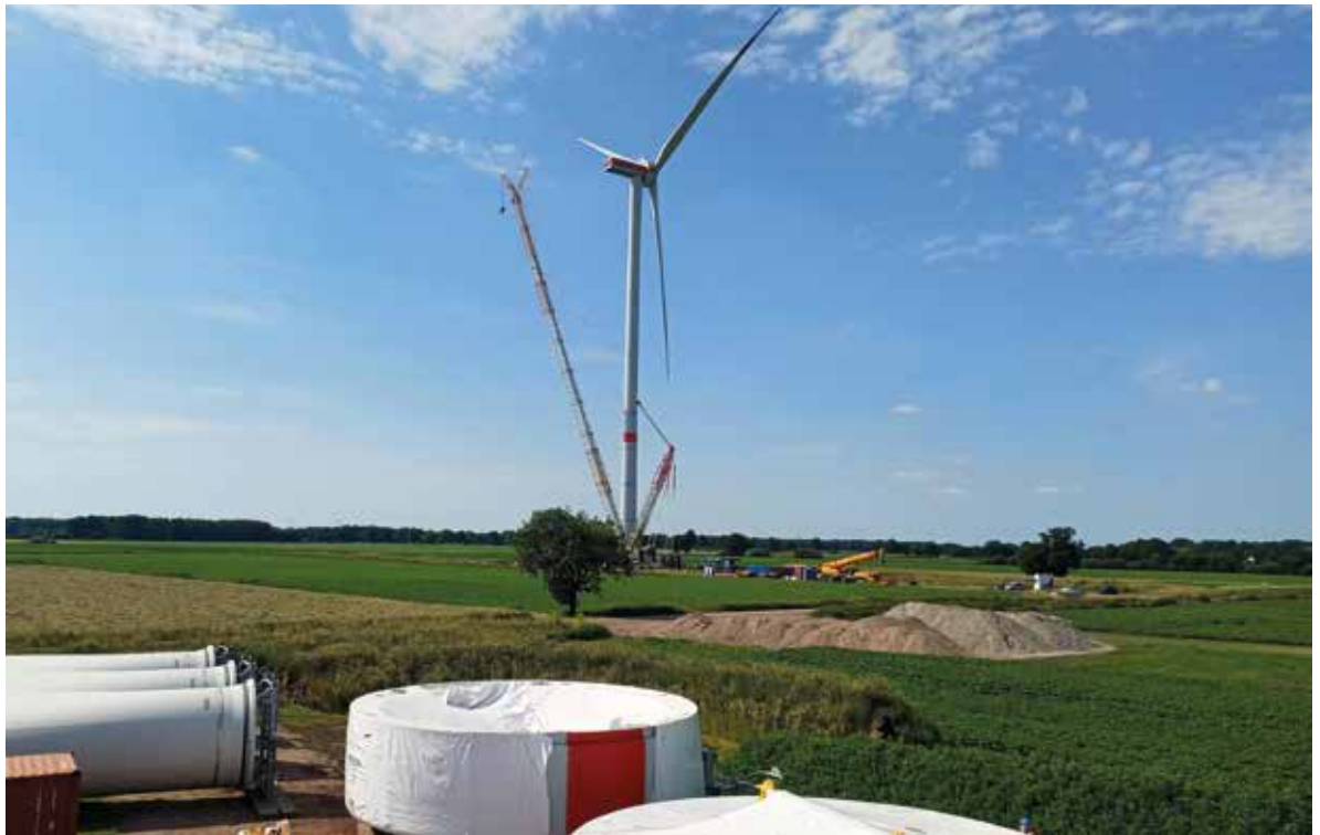
Die Bauarbeiten am Windpark Barver schreiten immer weiter voran.
